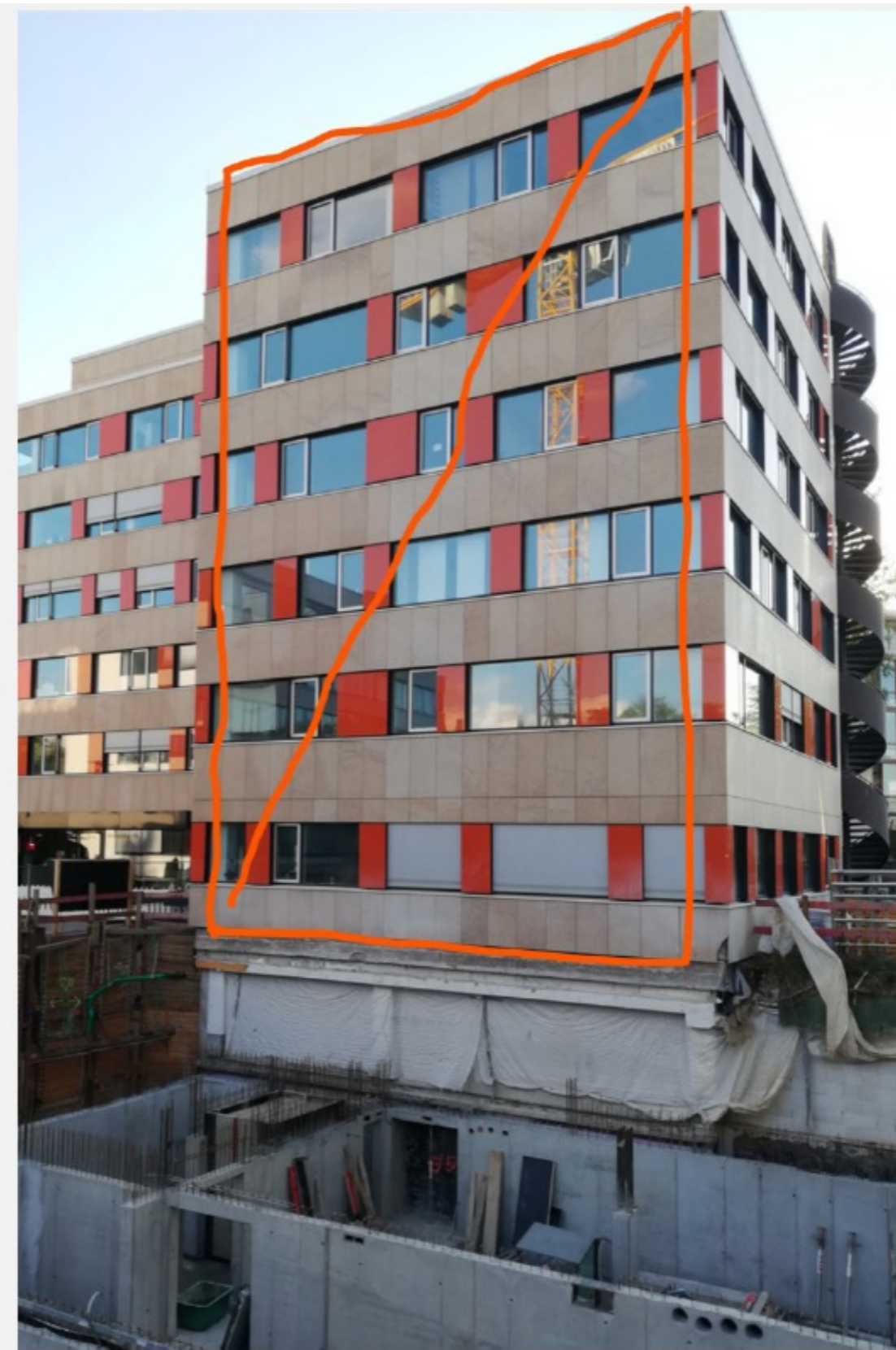
Quelle: Urbane Mine Pfosten-Riegel-Fassade zum Rückbau
